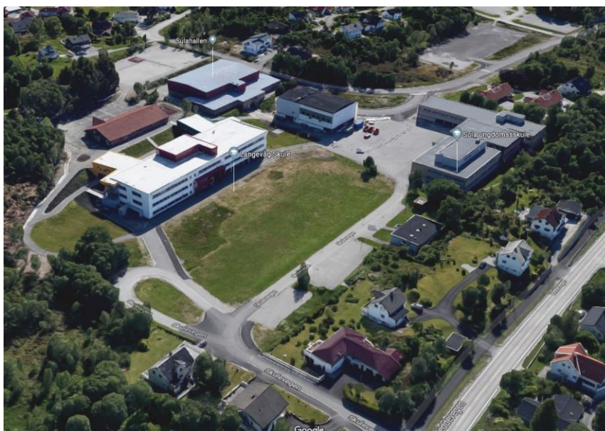
Figur 14: Bildet viser Langevåg barneskole til venstre, og Sula ungdomsskole til høyre. I bakgrunnen ser en Sulahallen.
