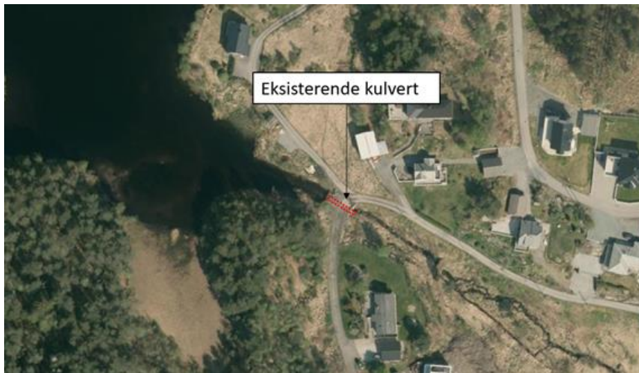
Figur 37: Eksisterende kulvert i Raudåna.
