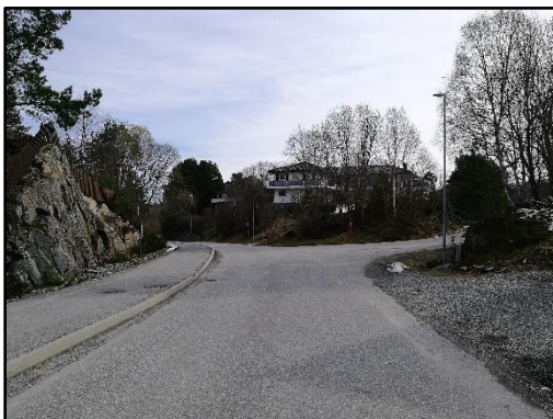
Bilde 4.1.6 – vegen Rørstadmarka, sett sydover, mot avkøyring Kringlevegen
