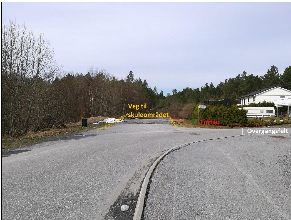
Bilde 5.5.3 – Forlenging av vegen Rørstadmarka, med nytt fortau og overgangsfelt
