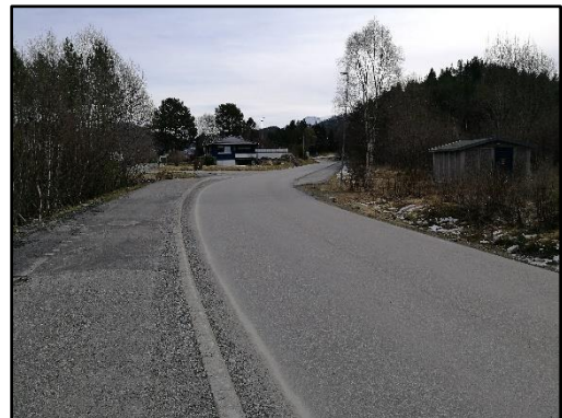
Bilde 4.1.5 – vegen Rørstadmarka, sett sydover, frå avkøyring til Rørstadmarka barnehage, Rørstadkrysset i bakgrunn
