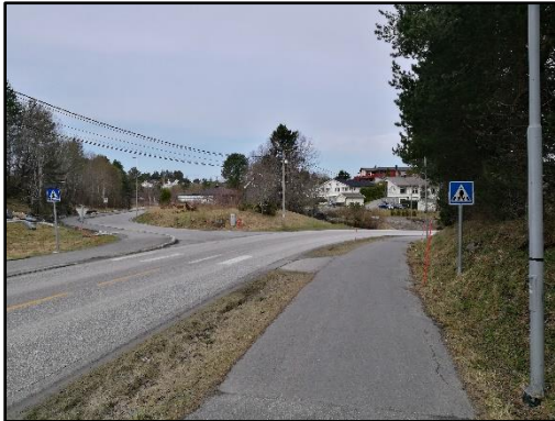
Bilde 4.1.2 - Rørstadkrysset, sett frå syd.
