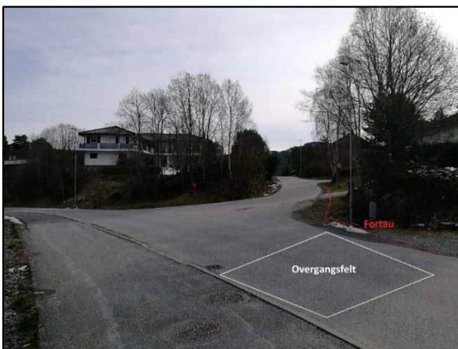
Bilde 5.5.2 – Nytt fortau frå Kringlevegen, med overgangsfelt på vegen Rørstadmarka
