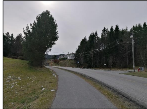
Bilde 4.1.3 - Rørstadkrysset, sett frå nord.
