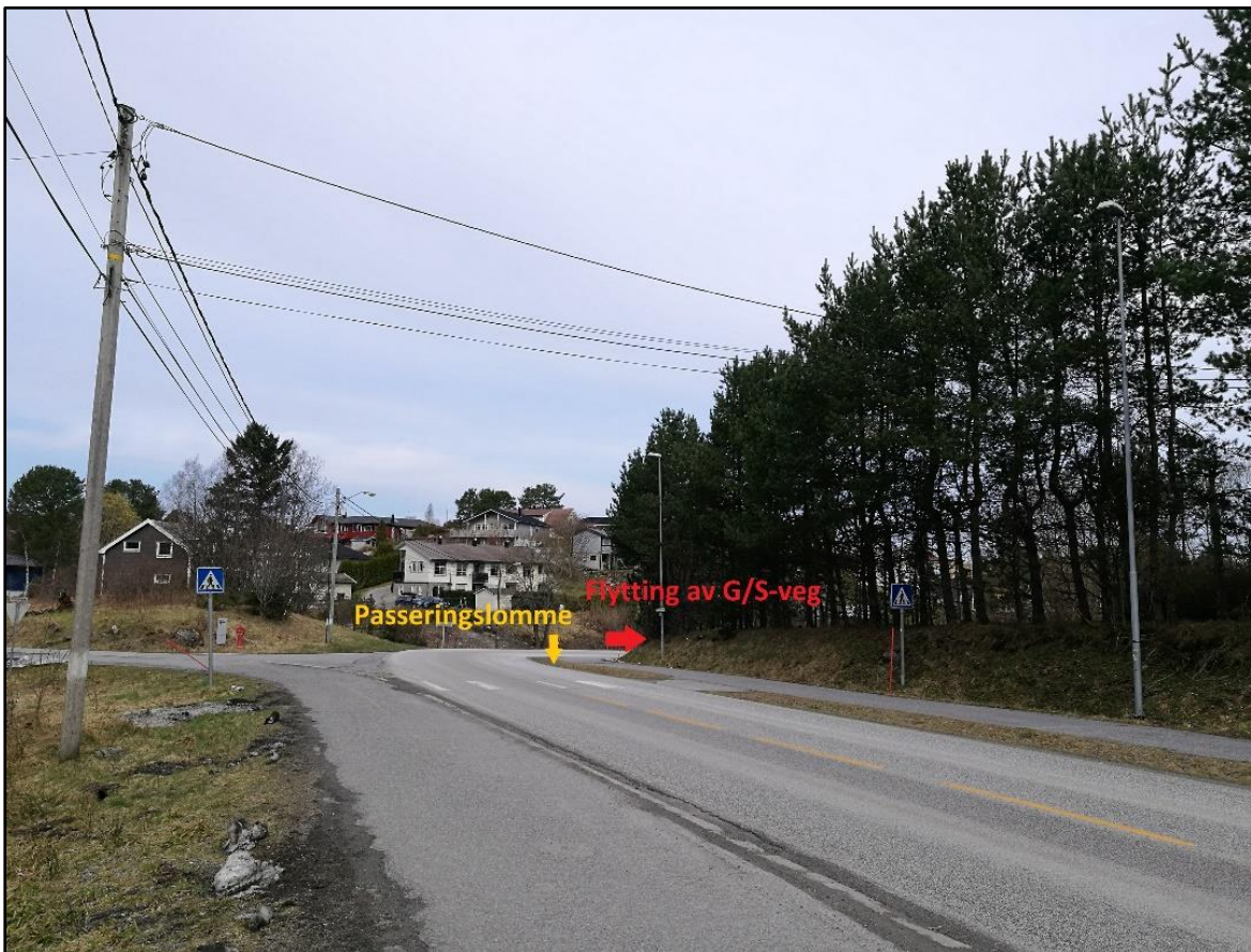
Bilde 5.1.6 – Illustrert plassering av passeringslomme på Fv 657, og forskyving av G/S
